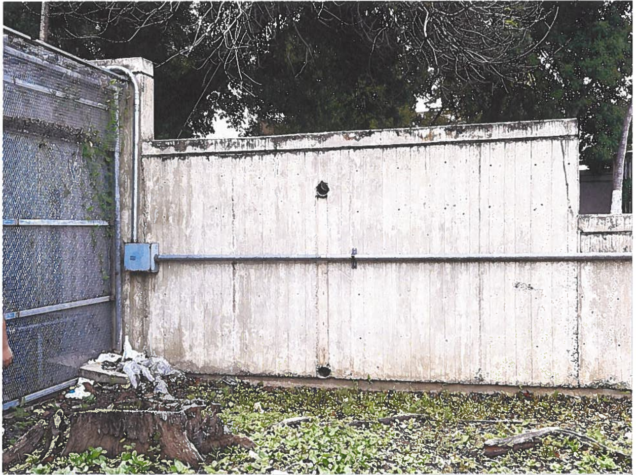
Caja de empalme
