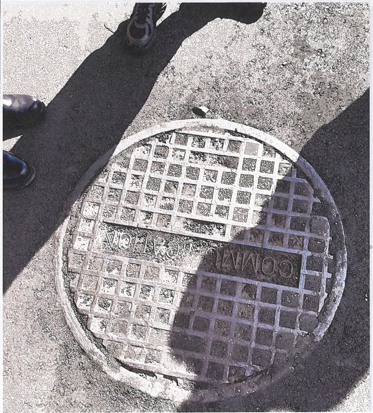
Manhole dentro del estacionamiento
