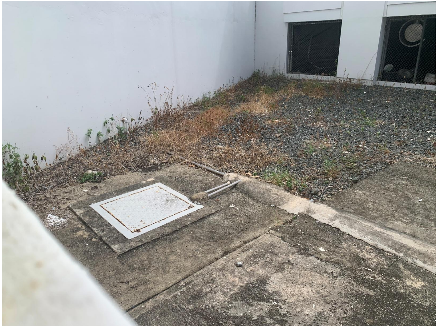
Foto de Subestación 5
